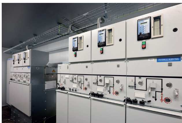
Mellanspänningsställverk, 22 kV.
